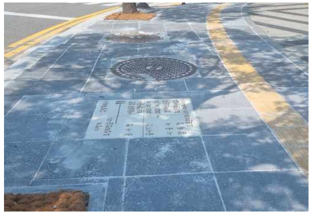
덕양구 화정동 어울림로 일원 보도정비 (공사이력판 설치)
